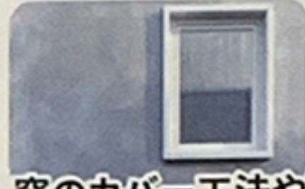
窓のカバー工法や 内窓設置
